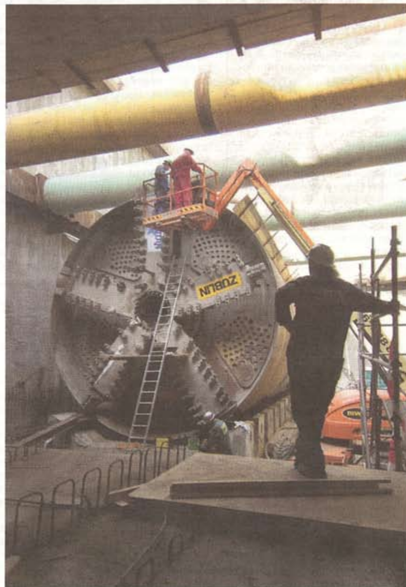
De Statentunnel in Rotterdam voor RandstadRail. Archiefphoto: Ton Borsboom
